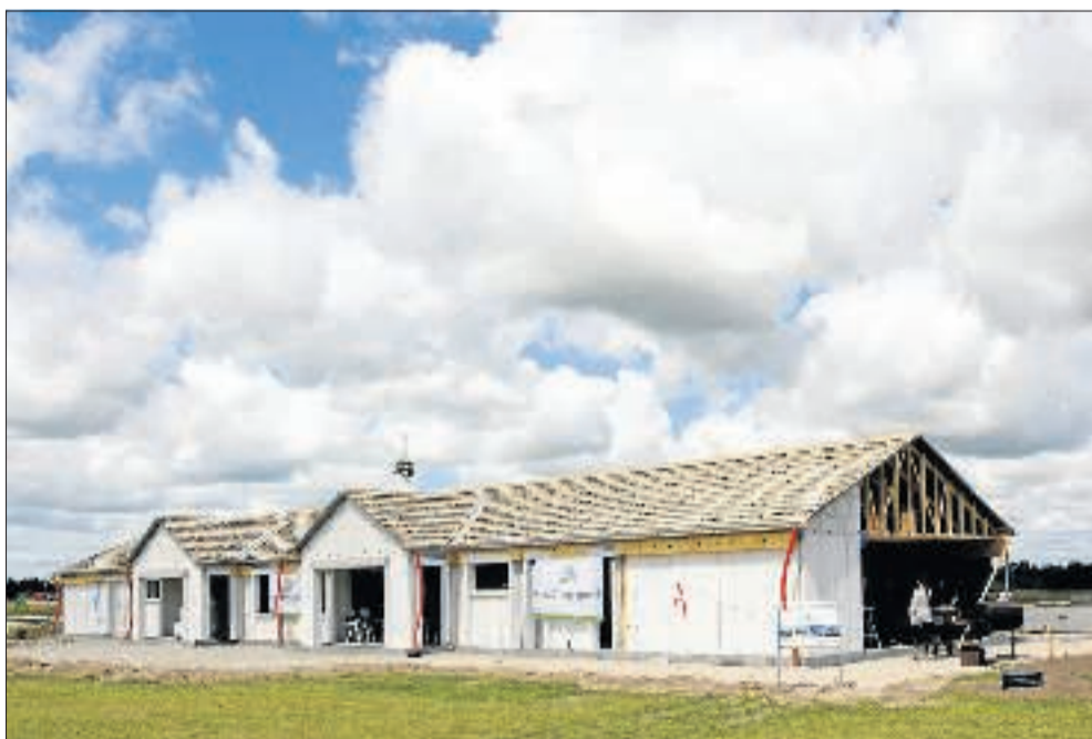
Byggeriet gik i gang i slutningen af marts og tager nu for alvor form. I alt får den nye ejendom godt 310 kvadratmeter beboelsesareal, og om en måneds tid bliver den gamle og svært beskadigede bygning så revet ned.
